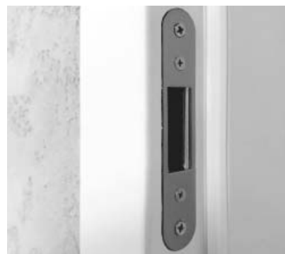
zaczep zamka magnetycznego w ościeżnicy
